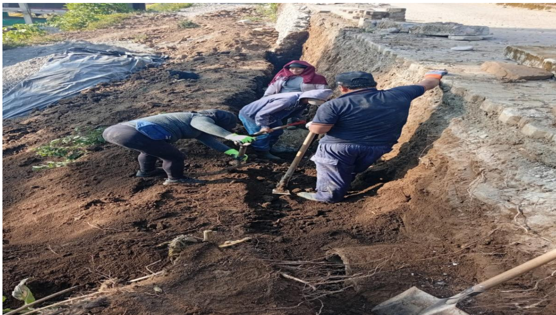
Fotografía 03: Construcción del muro en la comunidad de Cochapamba, en beneficio de la comunidad.
