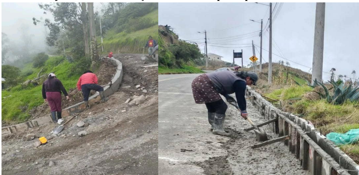
Fotografía 05: Mantenimiento Correctivo y Preventivo de los Espacios Públicos
