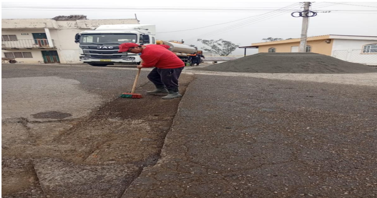
Fotografía 03: Trabajos de mantenimiento de la red vial
