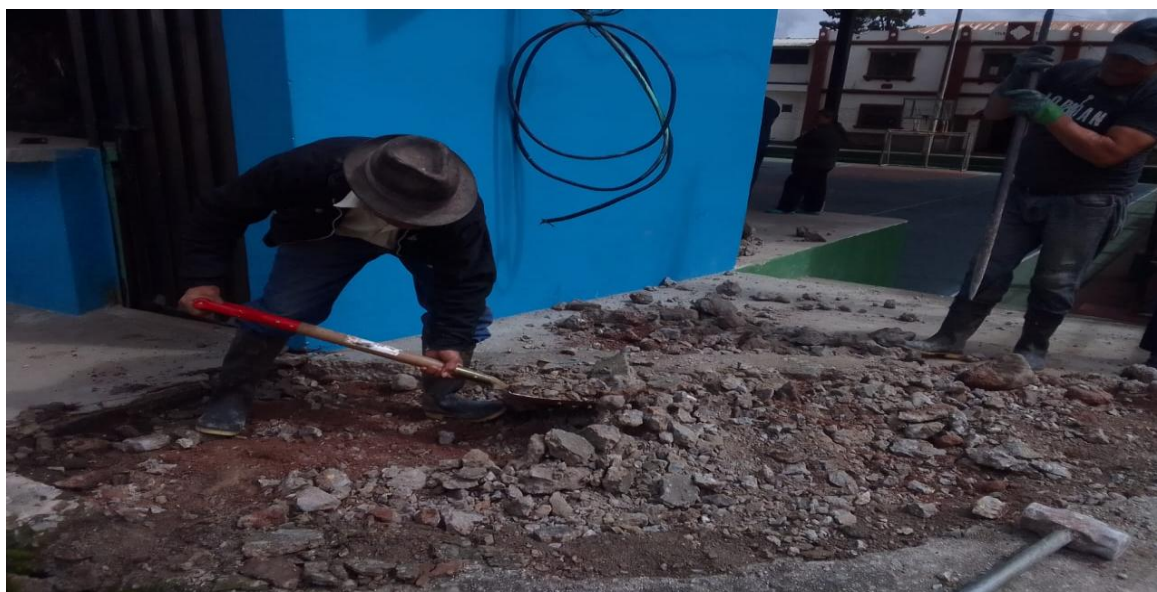
Fotografía 05: Trabajos de construcción de la rampa de acceso al escenario de la plaza central
