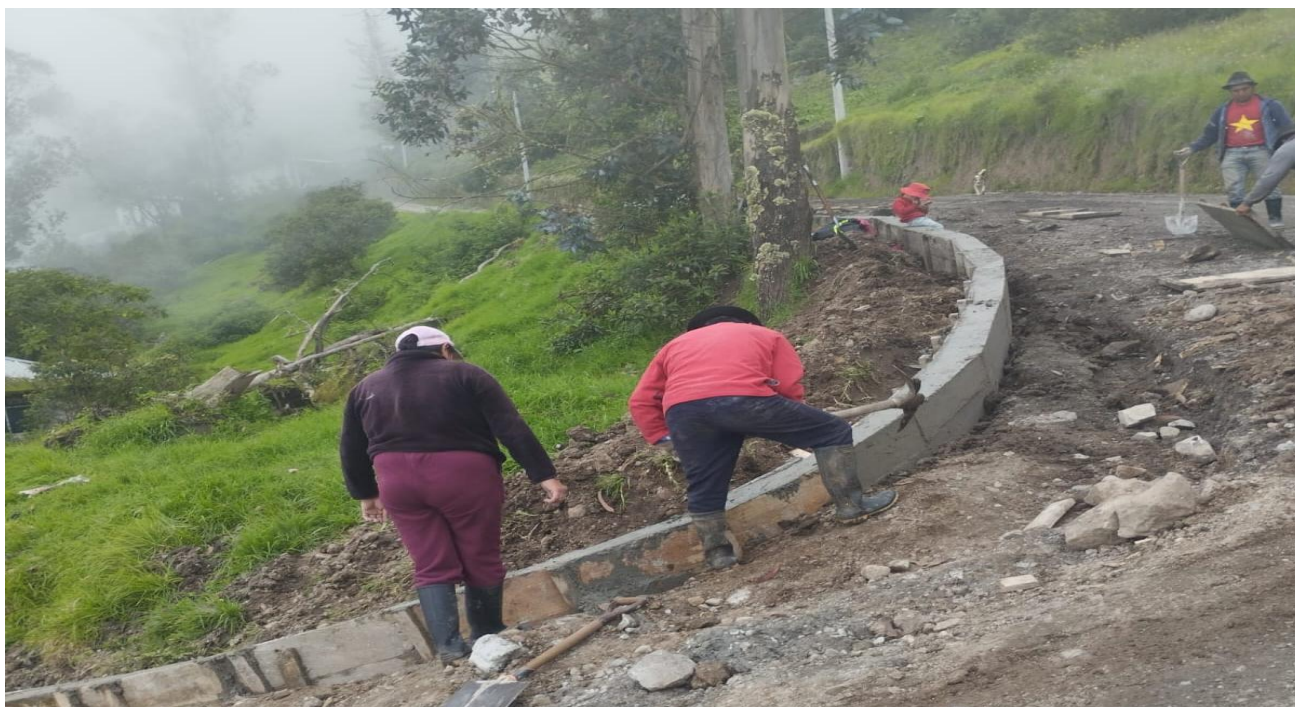
Fotografía 04: Trabajos de construcción de bordillo y adoquinado en la comunidad de Itus y San Martín
